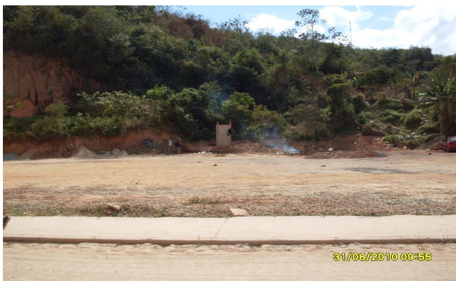
Foto 1 – Vista do local da construção da UBS-Barcelona – Situação em 31/8/2010
