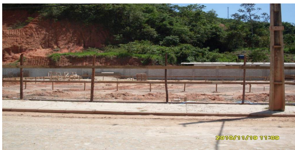
Foto 2 – Vista do local da construção da UBS-Barcelona – Situação em 19/11/2010
