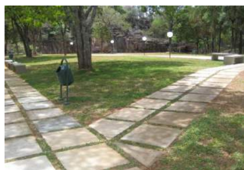
Foto 39 – Pavimentação da área externa concluída
