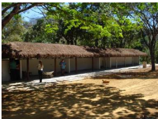
Foto 48 - Espaço destinado aos artesãos antes da conclusão da obra.
