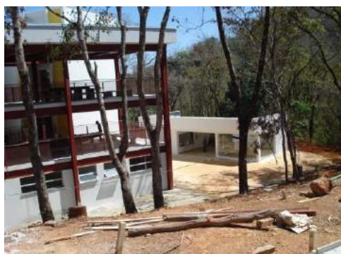
Foto 30 – Fachada do Receptivo Turístico ainda em obra
