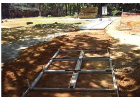
Foto 38 – Pavimentação da área externa em execução
