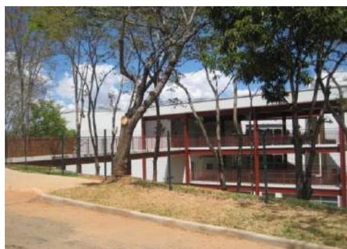
Foto 31 – Fachada do Receptivo Turístico após limpeza do terreno
