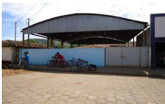
Foto 25 - Ponto de Distribuição cedido pela Prefeitura - Franciscópolis
