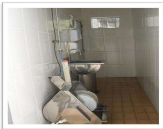
Foto 96 - Gabinete sanitário com dispositivo para higienização de botas e mãos
