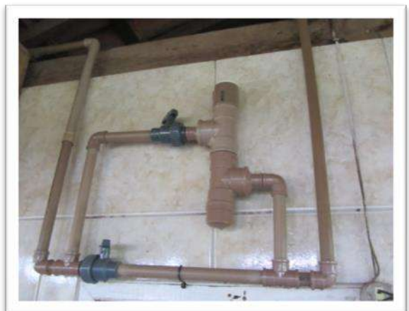
Foto 61 - Detalhe do sistema utilizado para a cloração da água
