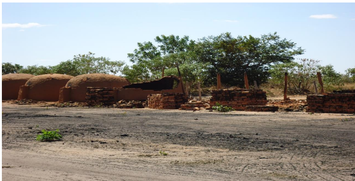
Foto 2: Faz. Santo Antônio - Bateria de Fornos 01 – Fase de desmonte
