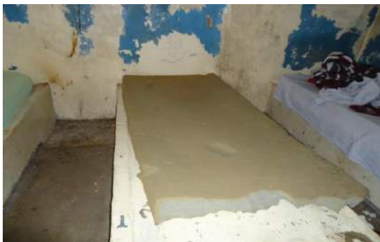
Colchão sem tecido e faltando pedaço
