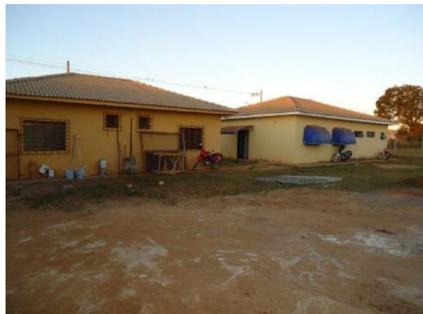
Fundos da unidade na parte de fora dos alojamentos, sem muro. Na frente estão as casas, onde ficam as salas de atendimento dos técnicos, sala de aula, enfermaria e da direção.
