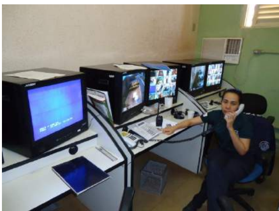
Monitoramento por Circuito Fechado de Televisão - CFTV
