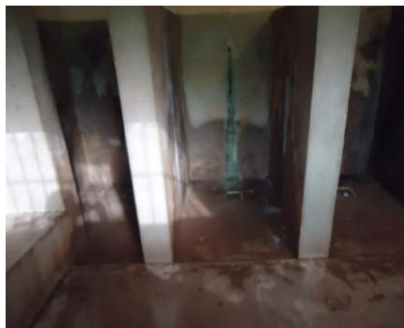
Núcleo I: O local do banho está cheio de infiltrações e é muito fétido
