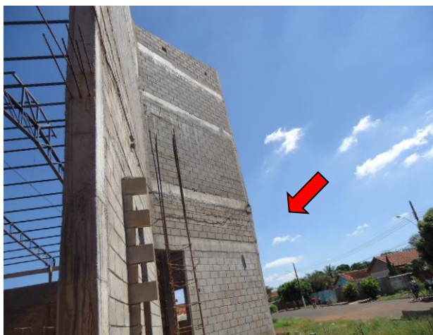
Fotos 9 e 10 – Inclinação de pilares e alvenaria
