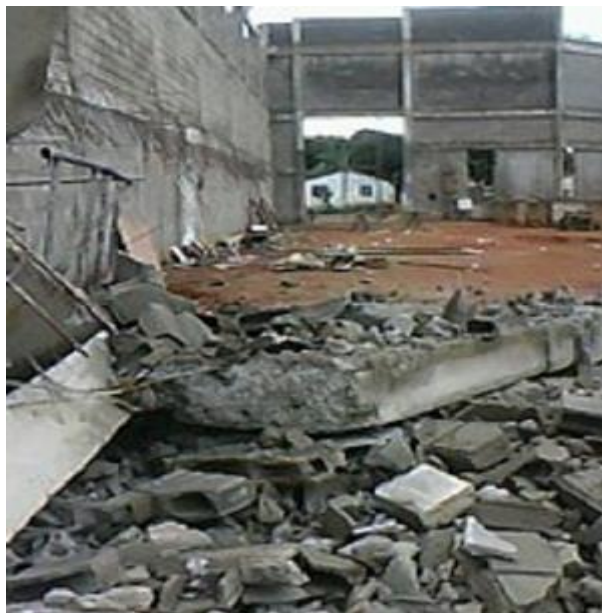
Fotografias 1 a 4 – Parte da estrutura de alvenaria das obras do ginásio poliesportivo que desabou
