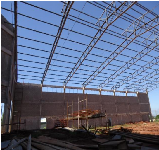
Fotografias 7 e 8 – Estrutura de cobertura (tesouras e terças) e ferragens expostas na alvenaria
