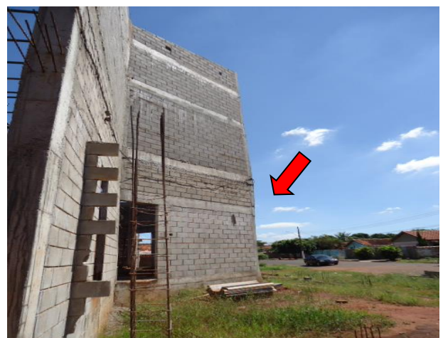
Fotos 9 e 10 – Inclinação de pilares e alvenaria
