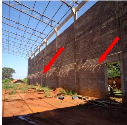
Fotografias 7 e 8 – Estrutura de cobertura (tesouras e terças) e ferragens expostas na alvenaria
