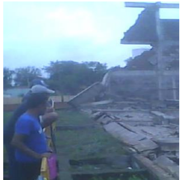
Fotografias 1 a 4 – Parte da estrutura de alvenaria das obras do ginásio poliesportivo que desabou
