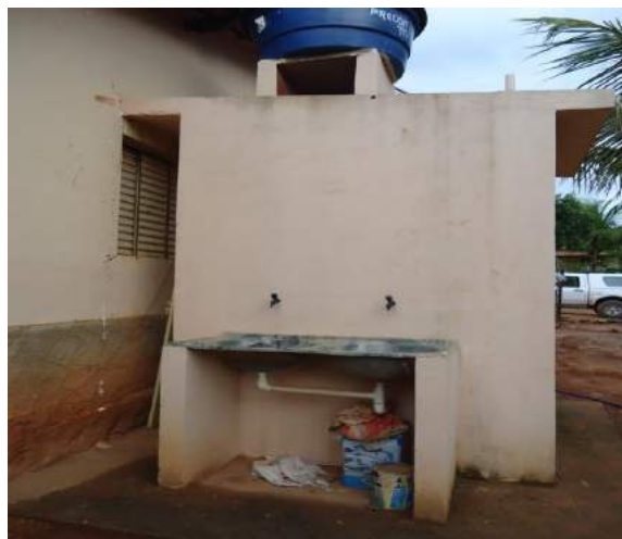
Fotos 83 e 84 - O beiral da laje não permitiu que o módulo fosse colado a janela do quarto.
