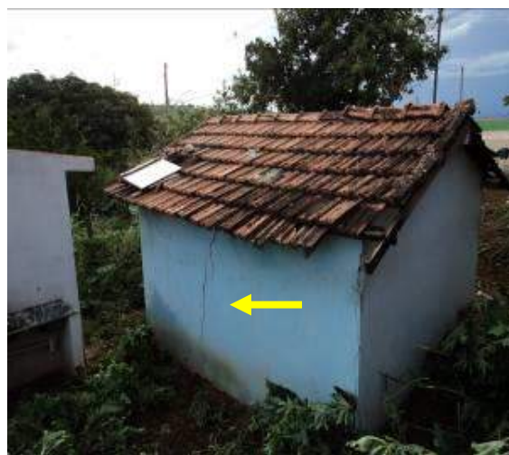
Foto 24 - Rachaduras verticais.
