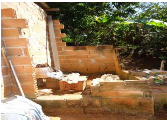
Foto 5 - Espaço separado para a construção do banheiro.
