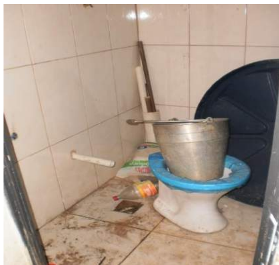
Módulos não finalizados (ausência dos componentes do banheiro).
