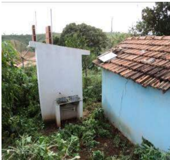
Módulos não finalizados (ausência dos componentes do banheiro).
