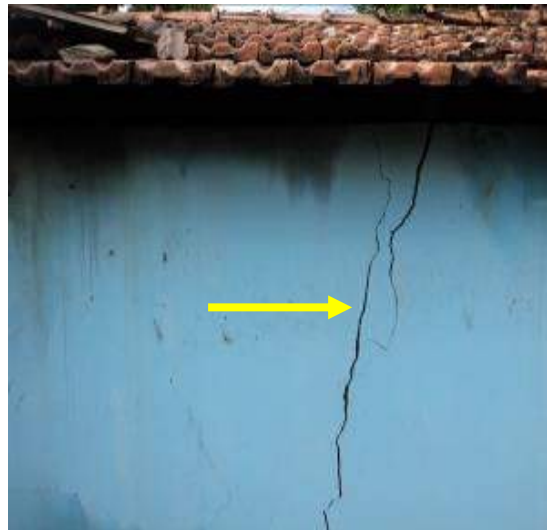
Foto 26 - Rachaduras verticais.
