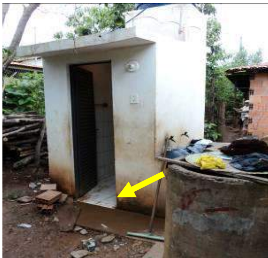
Piso interno desnivelado permitindo que a água do banho corra para fora.
