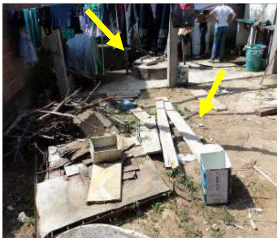
Fossa construída muito próxima da cisterna.
