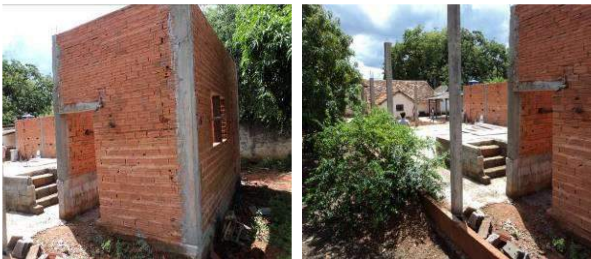
Fotos 27 e 28 - Obra do CRAS de Juramento.
