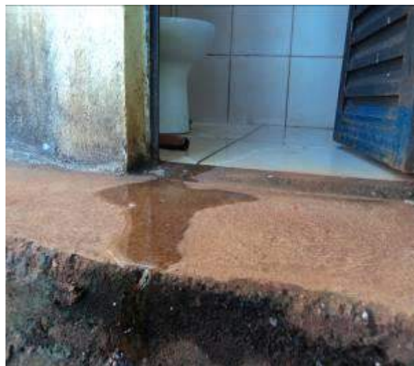
Piso interno desnivelado permitindo que a água do banho corra para fora.
