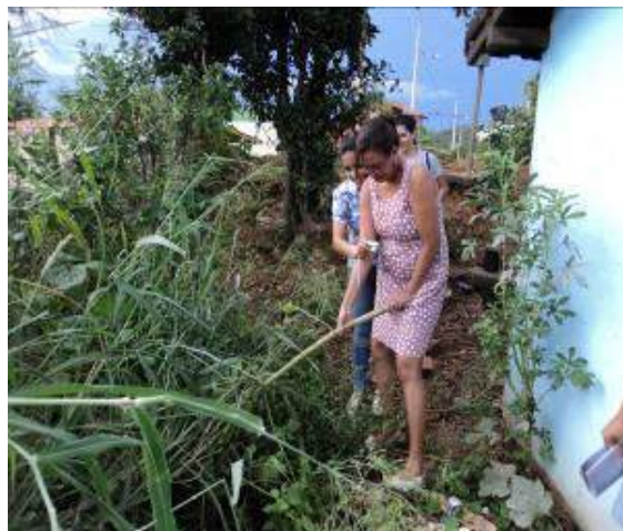
Foto 22 - Fossa a menos de 1,5 da casa, coberta pela vegetação.
