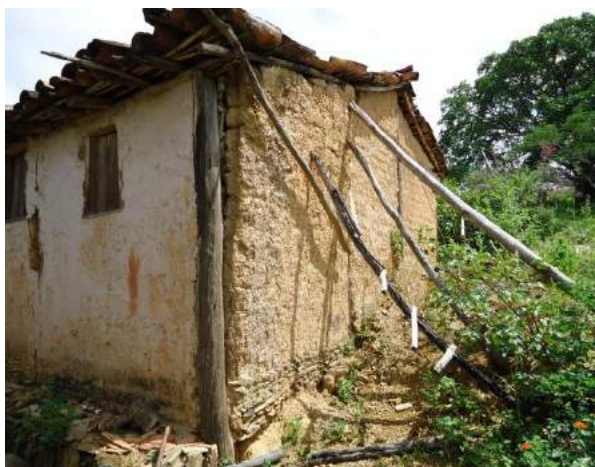
Foto 81 - Parede lateral escorada para não cair.
