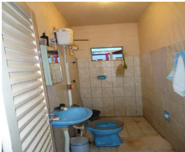
Foto 85 - Banheiro da residência do Sr. L.
