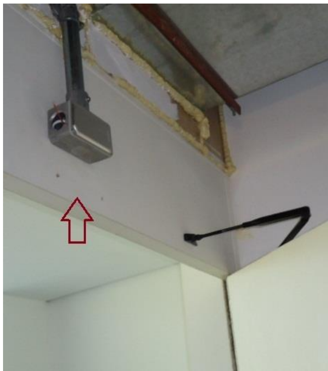
Sala com controle de acesso eletrônico sem maçaneta e sem o ímã da fechadura eletromagnética Sala “Instalações Hidráulicas/ Incêndio” da ala ímpar do 3º pavimento do Prédio Minas, 22/12/2012.
