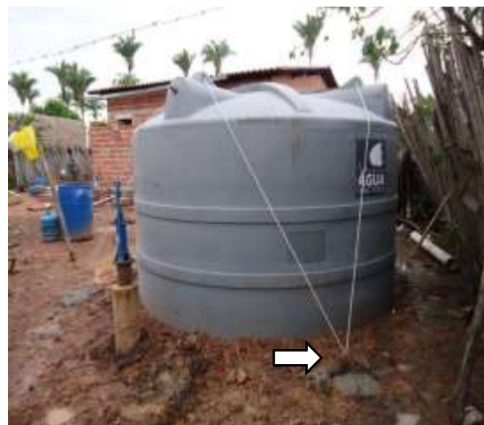
Foto 47 – Cisterna posicionada sobre o solo e fixada com cabo de aço.
