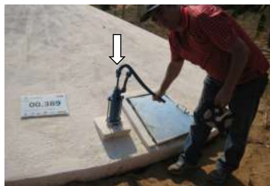
Foto 21 - Bomba da cisterna nº 00.389 de 2ª água - Chapada do Norte.
