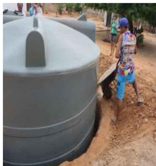
Foto 31 - Preenchimento das laterais.
