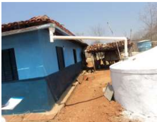
Foto 26 - cano acoplado à calha (cisterna nº 4.808) - Chapada do Norte.
