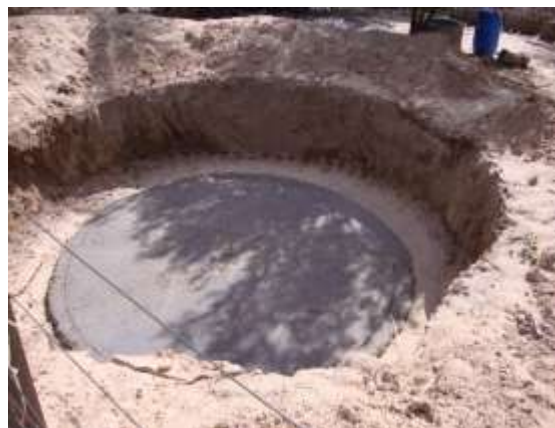
Foto 9 - Buraco com a base da cisterna já concluída – Januária.
