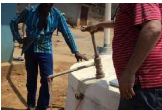
Foto 20 - Bomba da cisterna nº 4.808 de 1ª água - Chapada do Norte.
