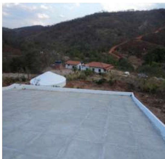
Foto 17 – Calçadão da cisterna de 2ª água (nº 00.386) – Chapada do Norte.
