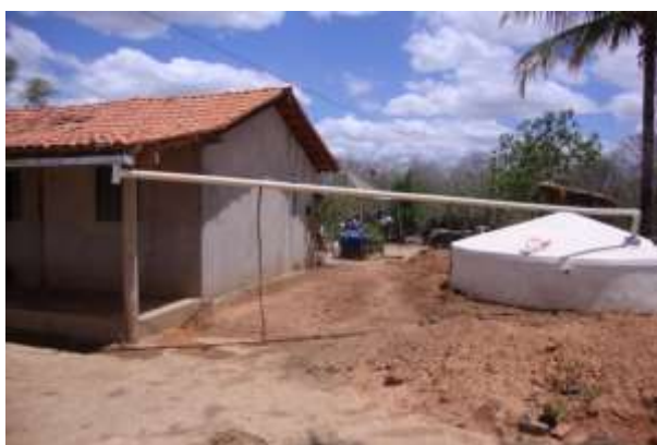
Foto 14 - Conexão da calha à cisterna (nº 13.042) - Januária.
