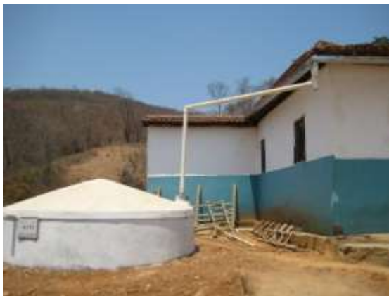
Foto 1 – Cisterna de placas 1ª água (16.000l)
