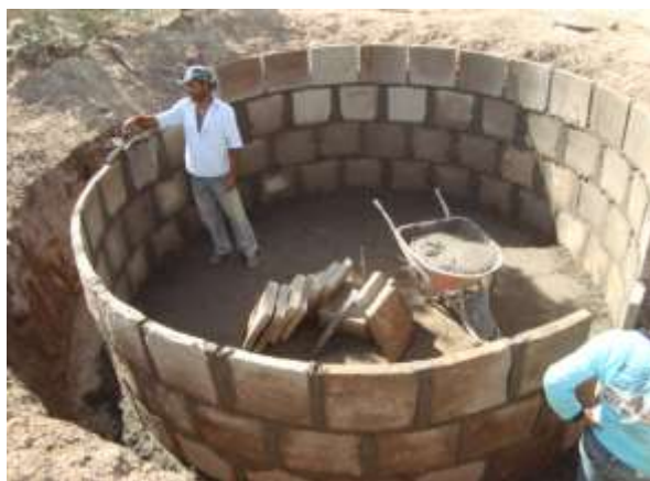
Foto 12 - Montagem da cisterna - Januária.
