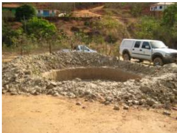
Foto 8 – Buraco escavado pela família – Chapada do Norte.
