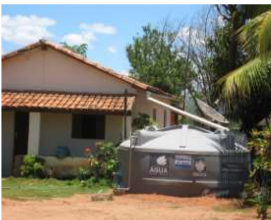
Foto 3 – Cisterna de polietileno
