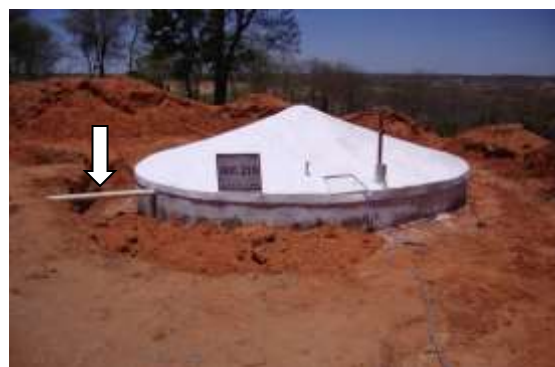
Foto 19 – detalhe do cano ligando o calçadão à cisterna (nº 000.219) de 2ª água – Januária.
