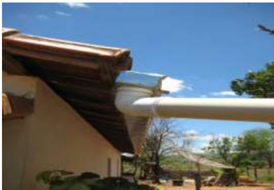
Foto 32 - Calha fixada (cisterna nº 00259).
