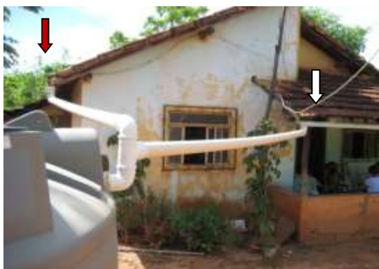
Foto 34 - Utilização de mais de uma área de telhado (cisterna nº 00782).
