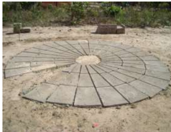
Foto 11 - Confeção das placas da tampa da cisterna - Januária.
