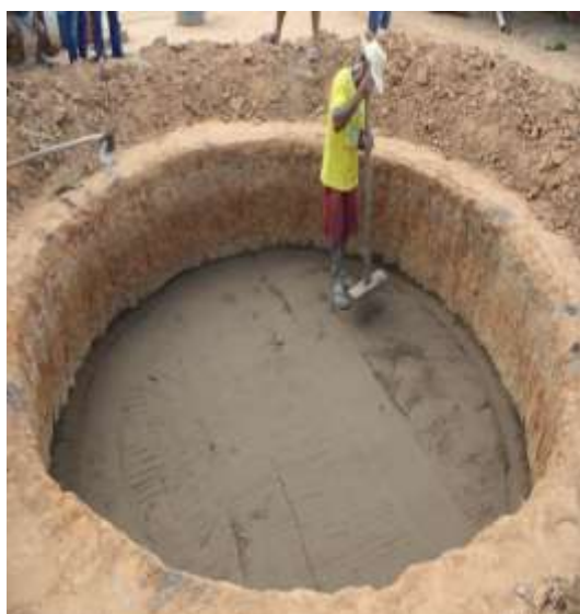
Foto 30 - Nivelamento do buraco com o composto solo/cimento.
