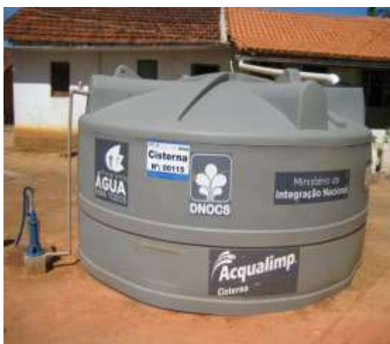
Foto 38 - Cisterna nº 00115 instalada adequadamente, sem amassados.
