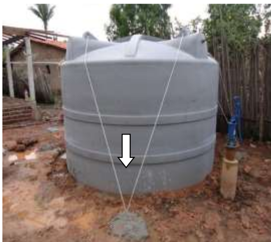
Foto 46 – Cisterna posicionada sobre o solo e fixada com cabo de aço.
