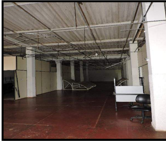
Figura 6 – Hall de entrada (UAITEC – Lagoa Santa)
